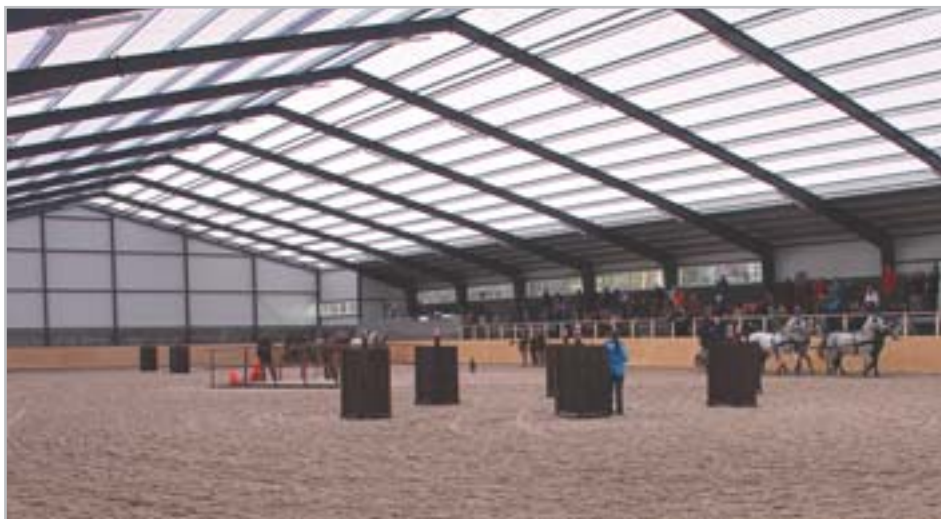
Nová hala ve Zduchovicích
